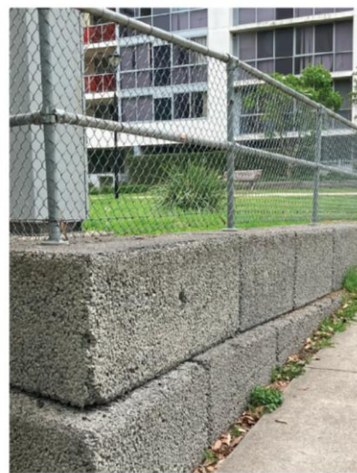
No dig fencing
